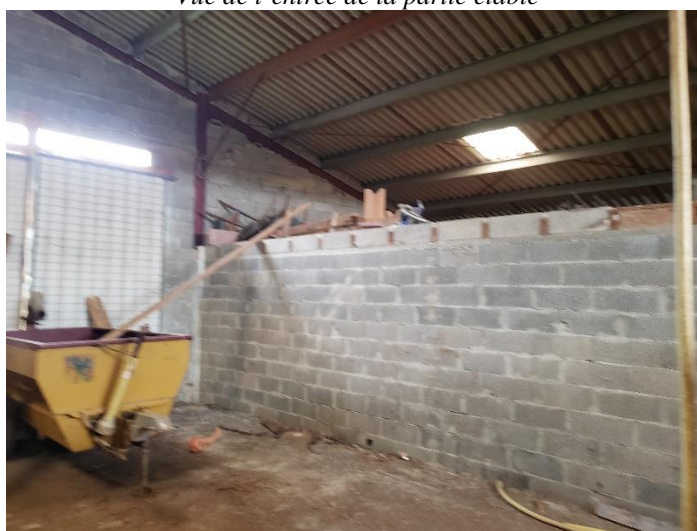
Détail du mur de séparation et fermeture en bardage tôles visible
