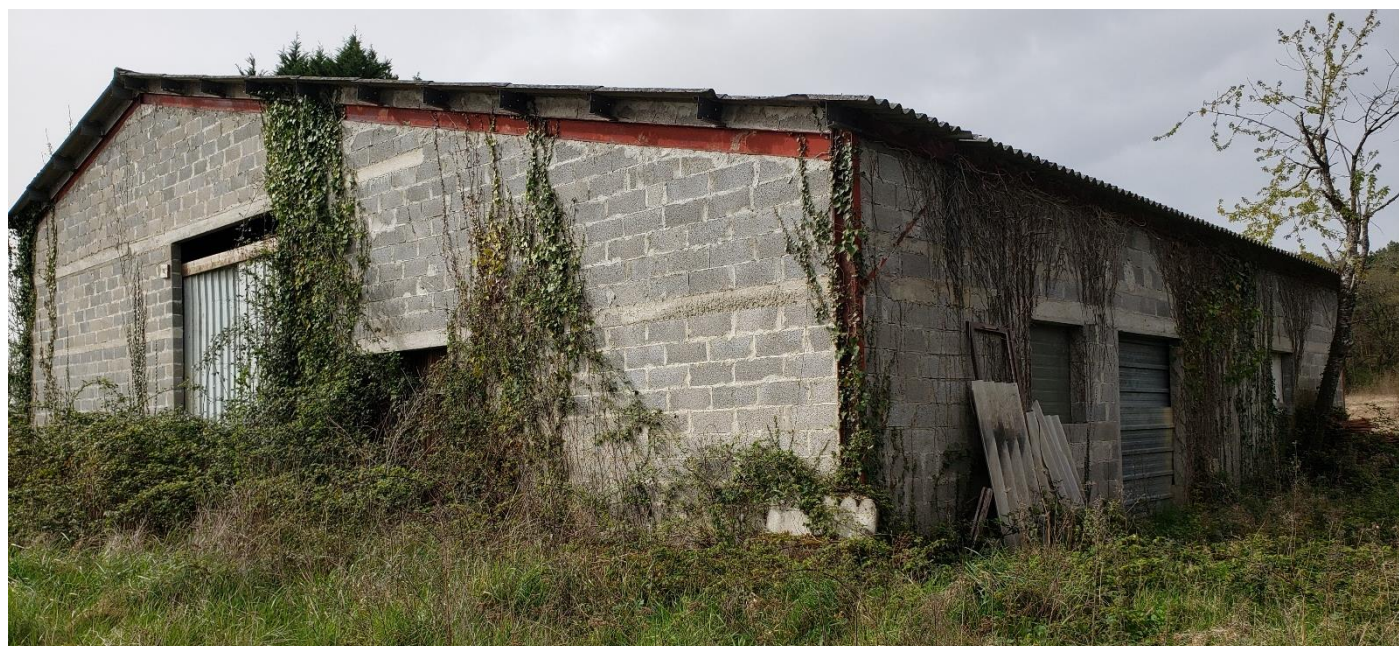
Hangar vu côté nord-est
