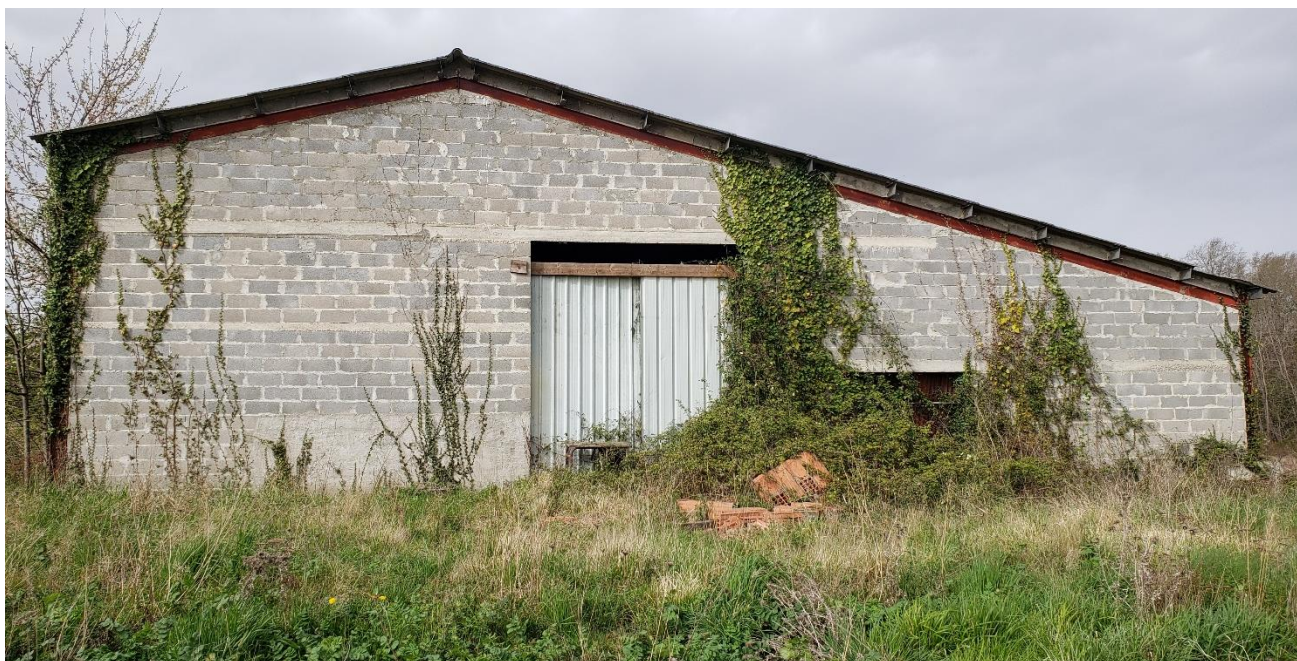
Hangar vu côté est
