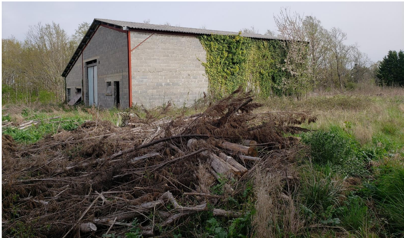
Hangar vu côté sud-ouest
