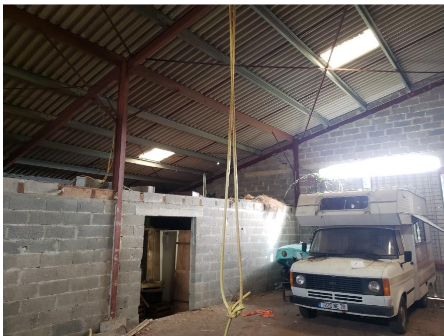
Vue intérieure du hangar avec une partie étable (derrière le mur en parpaings) et une partie stockage et garage (à droite)
