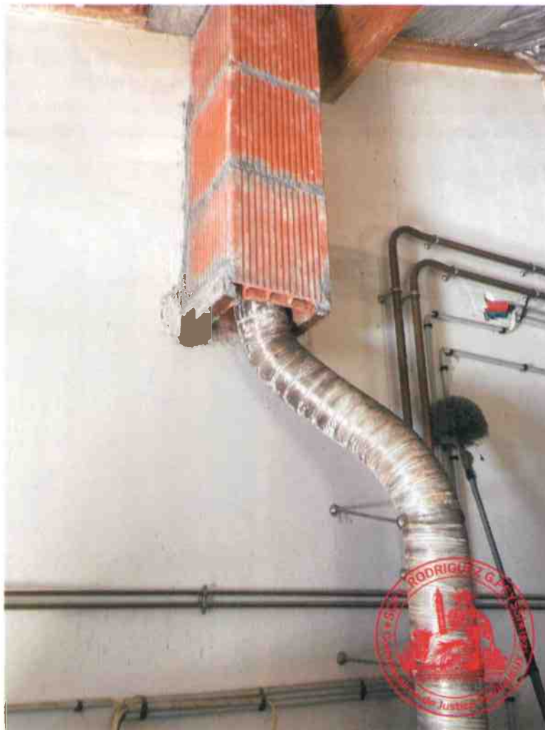
Au-dessus de cette chaudière, le conduit s'extrait au sein d'une souche de cheminée en briques.
